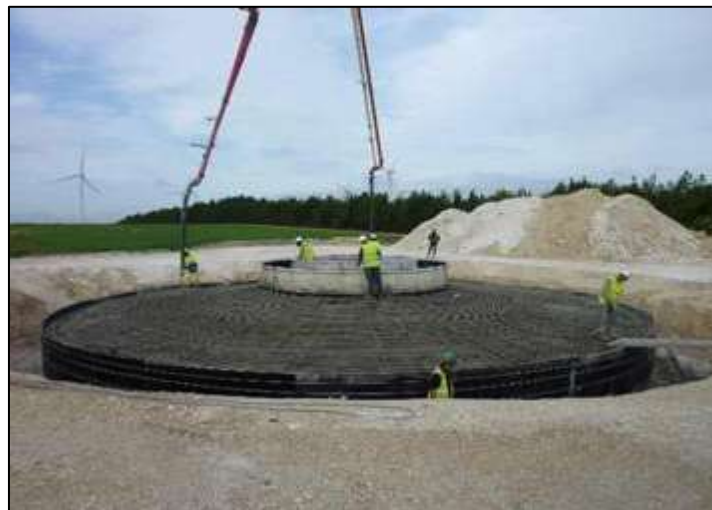
Figure 43 : Photographie de la mise en œuvre d'une fondation (Source : ABO Wind)
