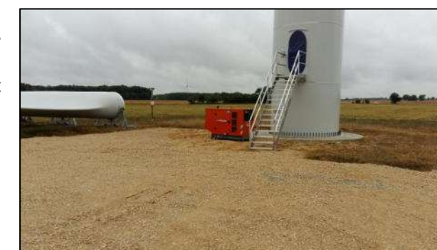
Figure 42 : Plateforme et zone de stockage (Source : ABO Wind)
