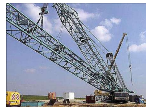
Figure 41 : Grue de levage sur une plateforme (Source : ABO Wind)
