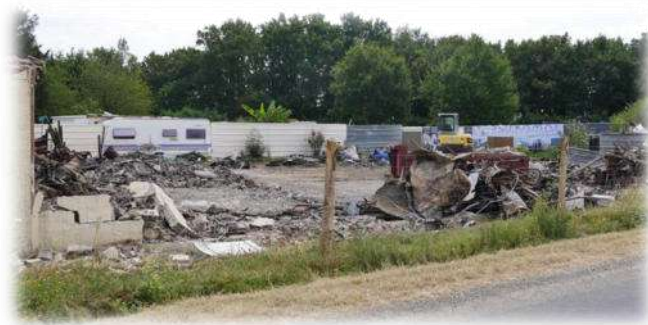
Figure 71 : Site BASIAS STAUB Walter au nord-est de l'AEI (Crédit photographie : NCA Environnement – 21 juillet 2020)
